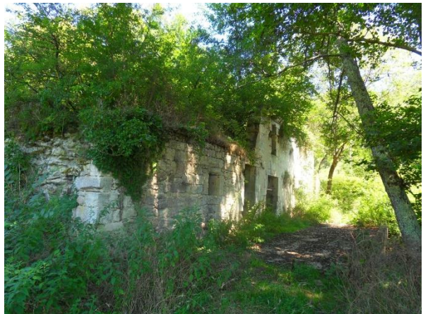
Ruine du moulin à eau de Caneville
